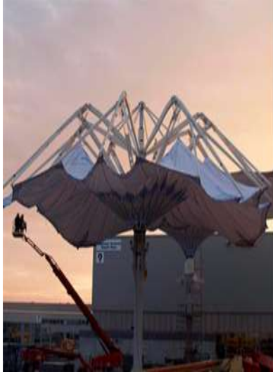
الشكل رقم (09-ب) الشكل العام للمظلة، أثناء عمل الاختبارات عليها
